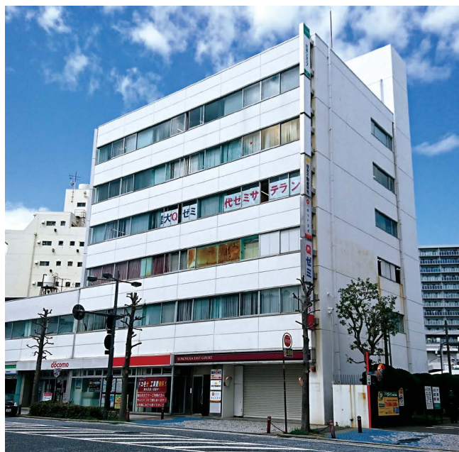
ビルの外観 京急本線横須賀中央駅から徒歩3分的好立地です。
